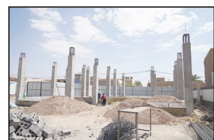
احداث ساختمان زورخانه شهرداری
