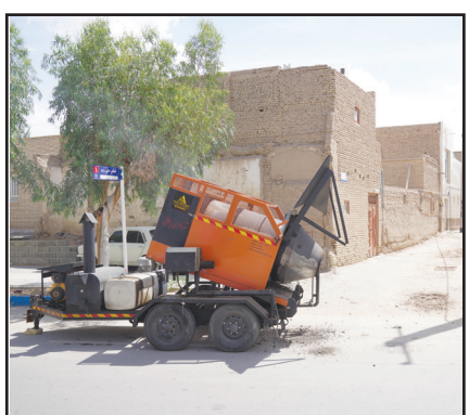
لکه گیری آسفالت معابر سطح شهر با دستگاه مکانیزه بازیافت آسفالت
