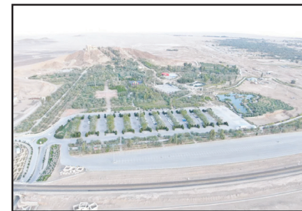
تکمیل عملیات عمرانی در گردشگاه آبشار بافق
