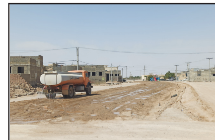
احداث بلوار آزادگان ( زیر سازی )
