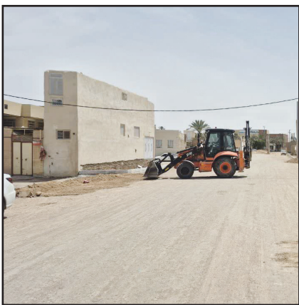
اصلاح مسیر ها و احداث خیابان های جدید ( خیابان شهید رئیسی )
