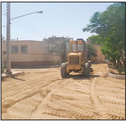
زیرسازی معابر و کوچه های سطح شهر
